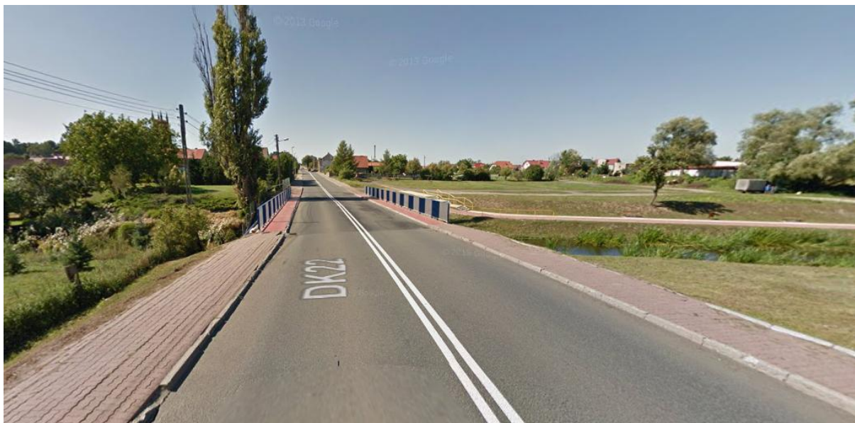
Zdjęcie 1. Droga krajowa nr 22 – miejscowość Dobiegniew
