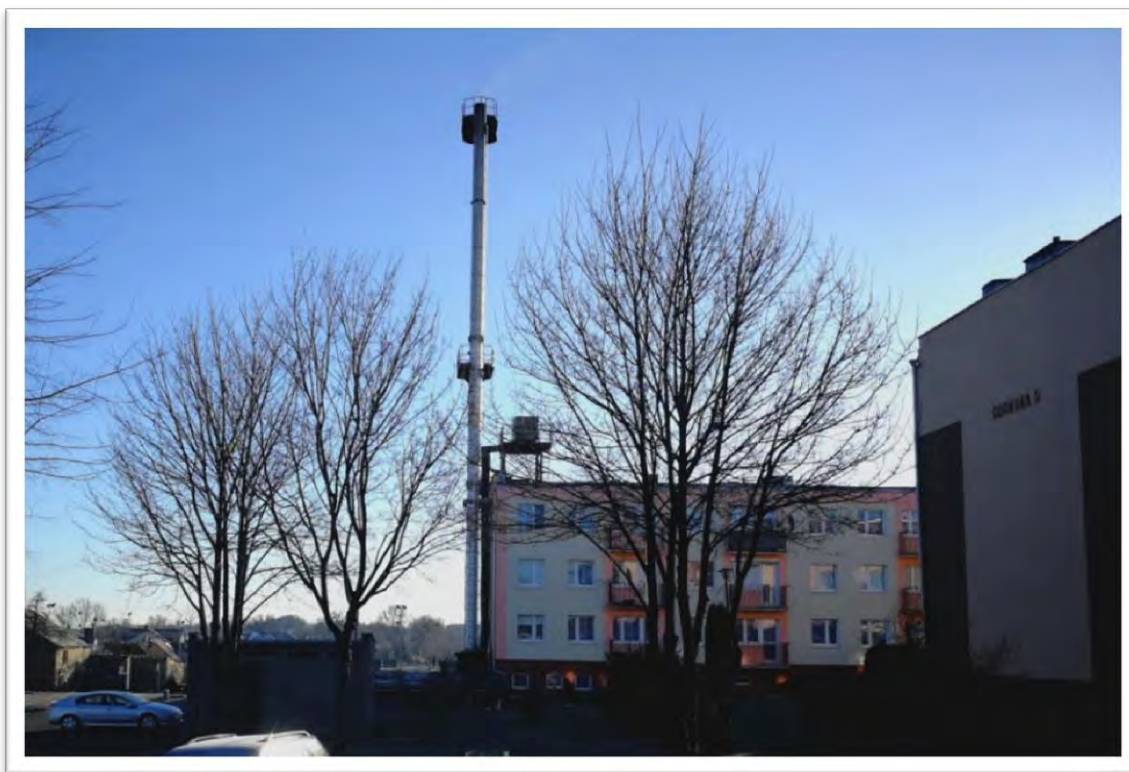
Zdjęcie 6 Widok na kotłownię obsługującą wybrane budynki na obszarze rewitalizacji
