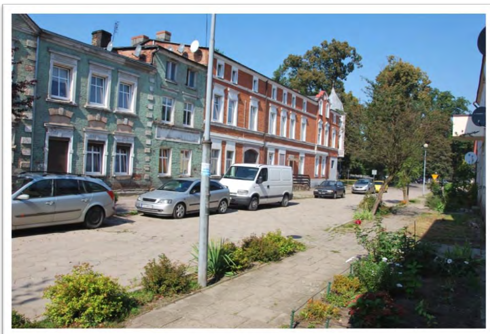
Zdjęcie 3 Budynki w złym stanie technicznym przy ul. Teatralnej
