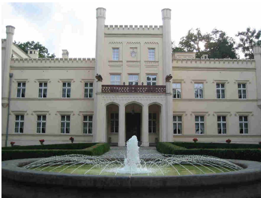
Fot. 1. Pałac w Mierzęcinie, źródło: fotografia własna
